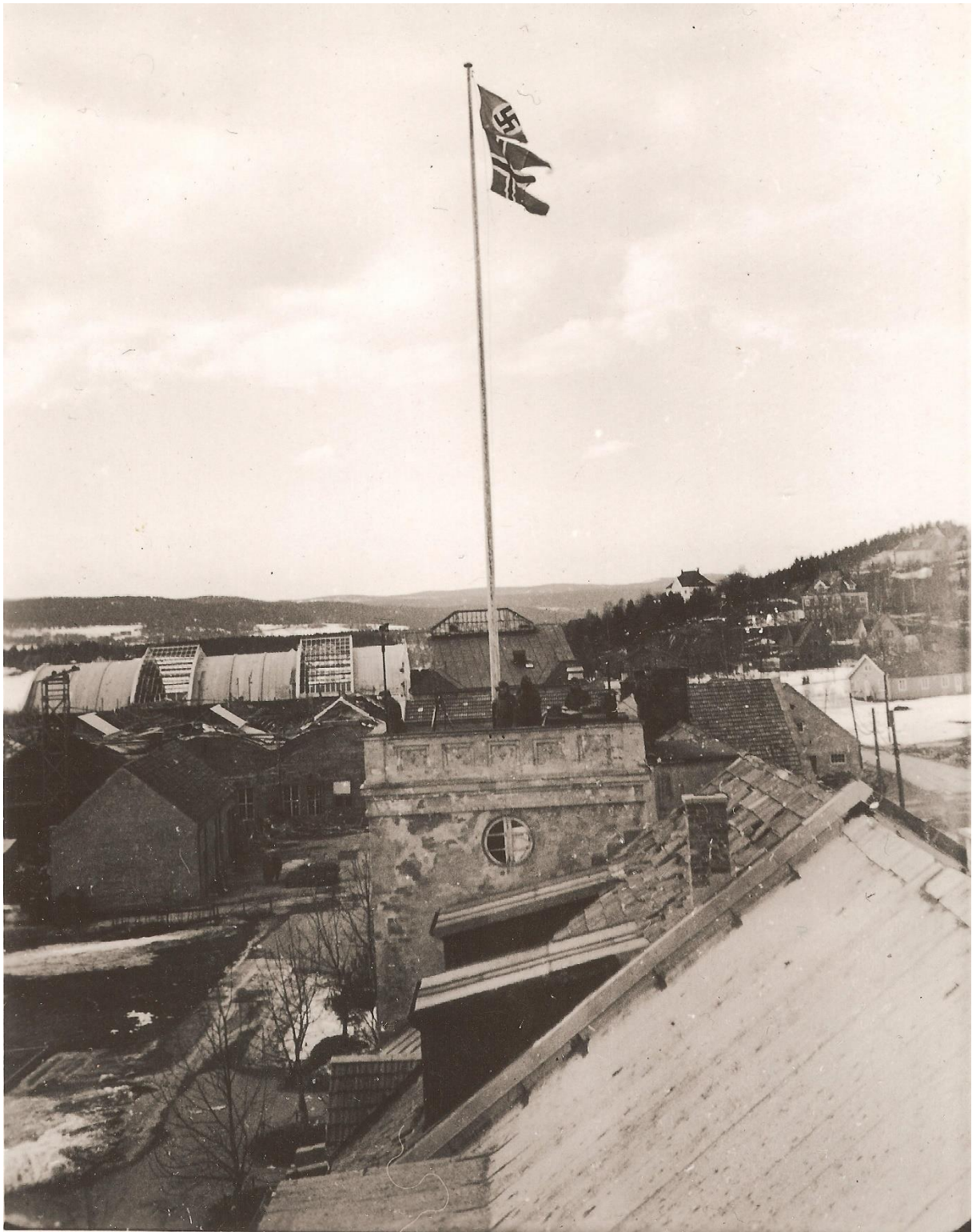
41April 1940, Hakekorset og det norske flagget på samme flaggstang, luftvernstilling i tårnet til flyskolen. Nærmest sees taket av første utvidelse av flyskolen. på flyfabrikken sees første og andre byggetrinn samt forskaling Foto: Jo Bakken
