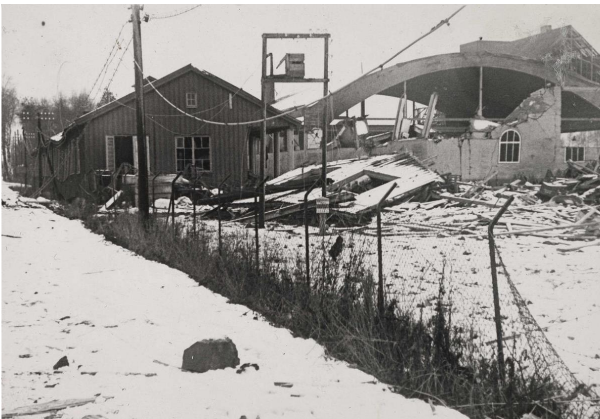
47 Utbombet flyskur på Kjeller, merk den tyske kamoufleringen som gårdsbygg på toppet av hallen Foto: Akershusbasen
