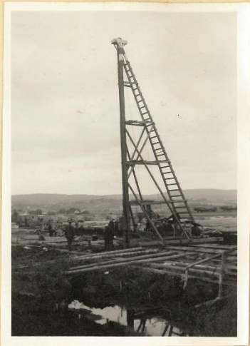
8 - Einrahmen der Pfähle
