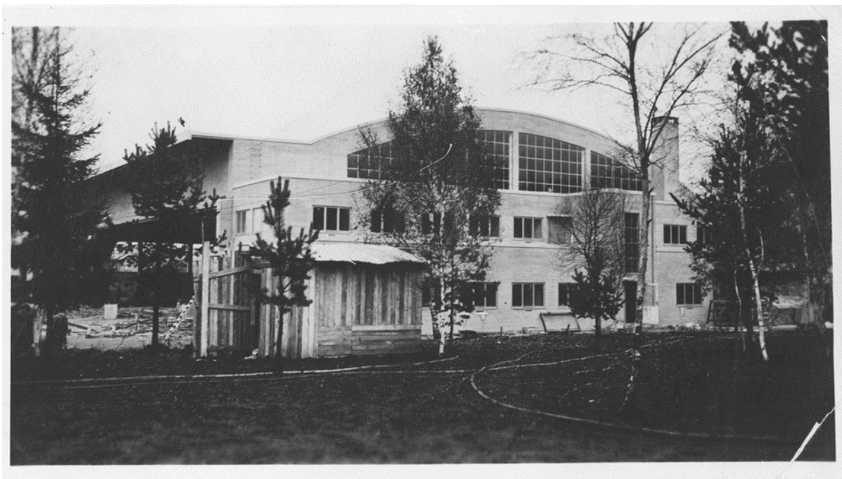
23 Jagerbataljonens hangar "det grønne bygget" reist i 1939, BMW verksted under okkupasjonen og bombet i 1943 og 1944. Nærmest står «Fotobygget» som er den delen av bygget som står i dag Foto: Akershusbasen
