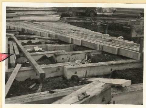
11 - Startbahn aus Hochkaut- Plauken-Verband auf Pfahlrost.
